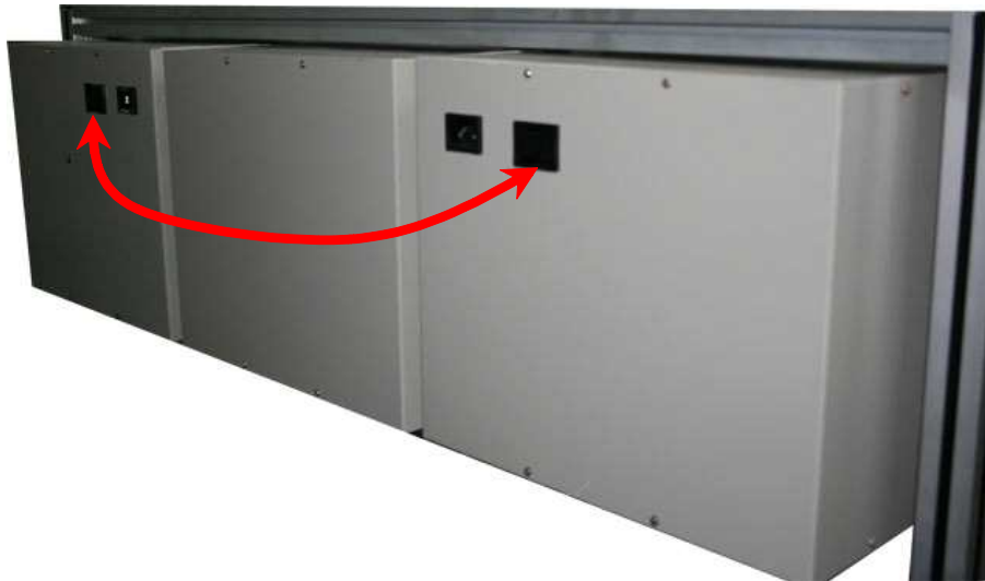
N.F.B 설치된 제어판 뒷면
